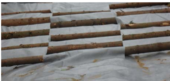
Рис. 6. Опытный участок с устройством поперечного настила, переплетенного геосинтетическим материалом
