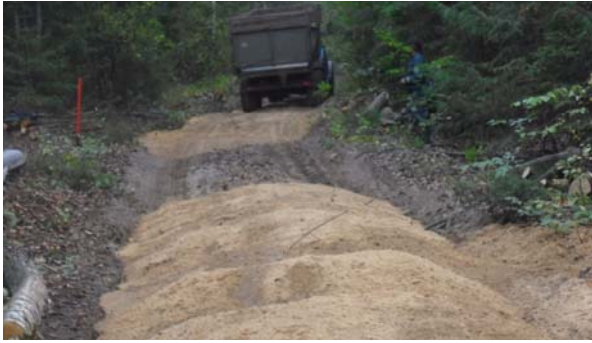
Рис. 4. Транспортировка и отсыпка грунта
