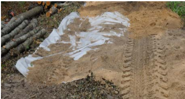
Рис. 5. Опытный участок с использованием геосинтетики и хворостяной выстилки
