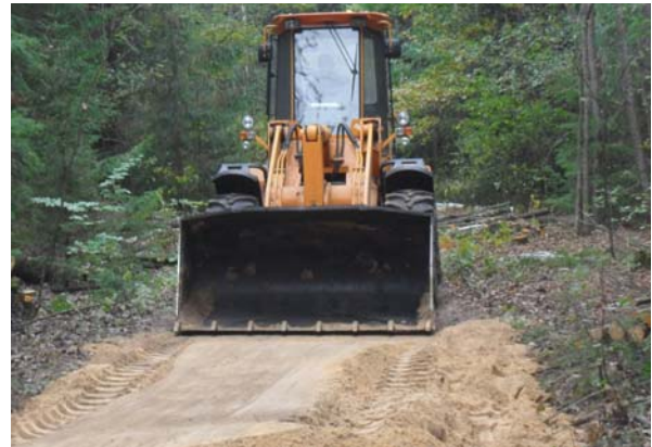
Рис. 7. Разравнивание покрытия погрузчиком «Амкодор»
