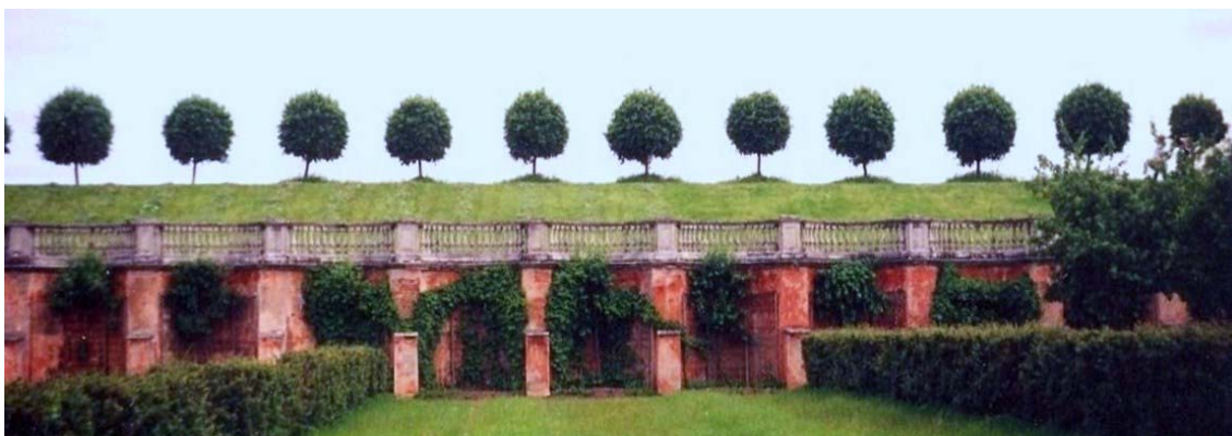
Рис. 15.1. Подпорная стенка из полуцилиндрических секций в композиции насыпного вала на участке дворца Марли (Петергоф, Россия)
