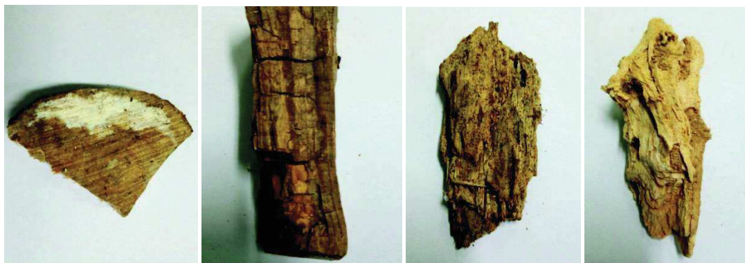
Рисунок 1 – Образцы поврежденной древесины
