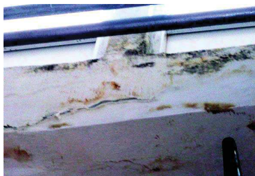
Рисунок 1 - Дефекты лакокрасочного покрытия
