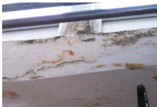
Рисунок 1 - Дефекты лакокрасочного покрытия
