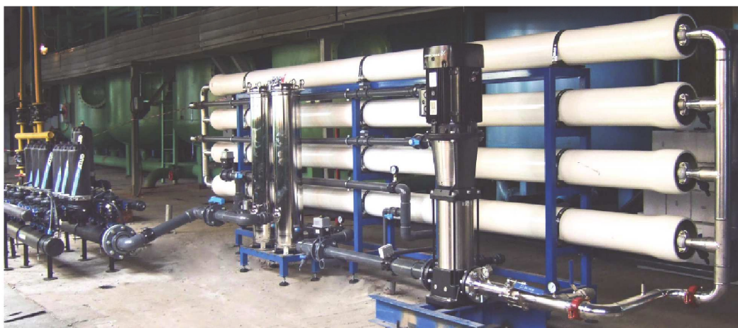
Рисунок – Общий вид опытной установки нанофильтрации в химическом цеху Полоцкой ТЭЦ
