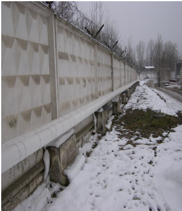
Малюнак 5. Ачышчальныя будынкі прадпрыемства з падводамі злучэння пагрузнага цеплаабменніка з трубамі прамежкавага контуру
