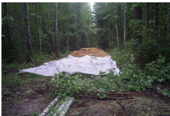
Рис. 6. Строительство опытных участков: а – отсыпка земляного полотна лесной дороги; б – разравнивание слоя земляного полотна; в – общий вид устраиваемой дорожной конструкции
