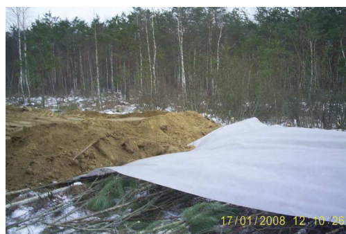
Рис. 4. Строительство опытного участка в Осиповичском лесхозе
