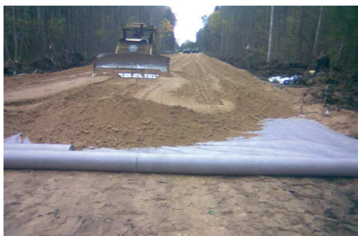
Рис. 3. Строительство опытного участка в Быховском лесхозе
