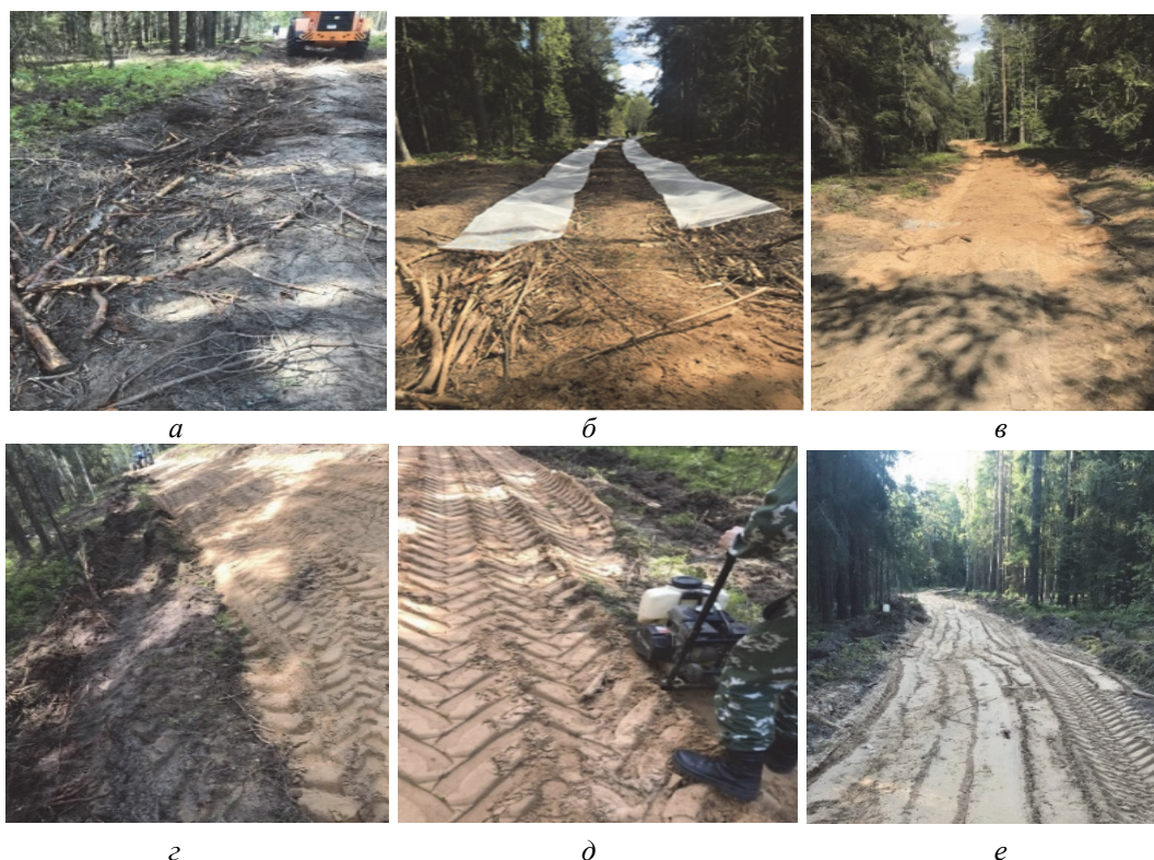
Рис. 10. Этапы устройства дорожной конструкции из хворостяной выстилки и лент стекловолкна:
