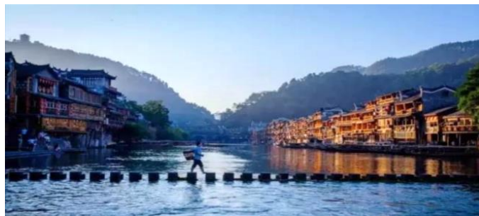
Рисунок 6 – Мост «Тяо Цяо» в уезде Фэнхуан провинции Хунань
