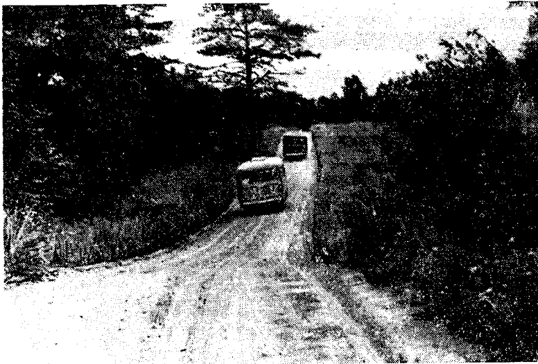
Рис. 2—7. Гравийная лесовозная дорога с однополосной проезжей частью
