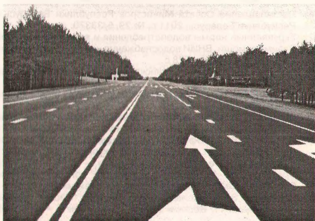
Рис. 2. Общий вид дорожной разметки
