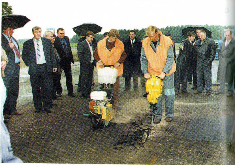
Ознакомление участников семинара с оборудованием и инструментом для ремонта автомобильных дорог
