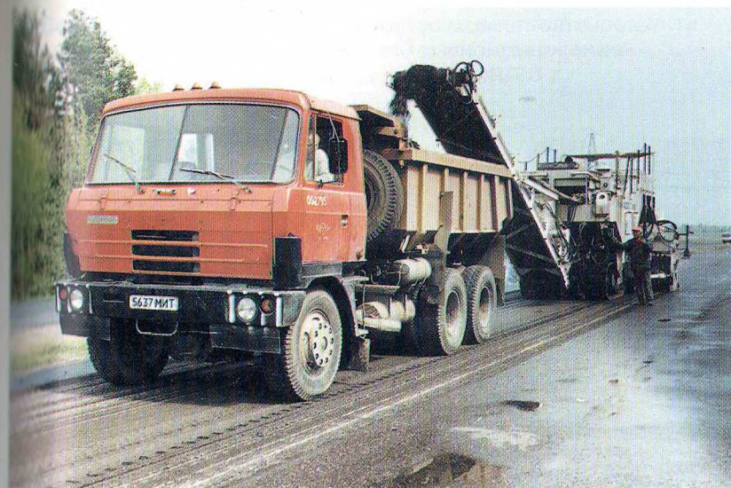
Холодное фрезерование асфальтобетонного покрытия на участках колееобразования. 1996 г.
