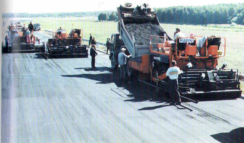
Устройство асфальтобетонного покрытия при модернизации дороги М1/Е30 тремя асфальтоукладчиками. 1996 г.
