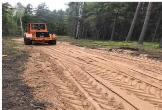
**Рисунок 11 – Отсыпка насыпного слоя**
