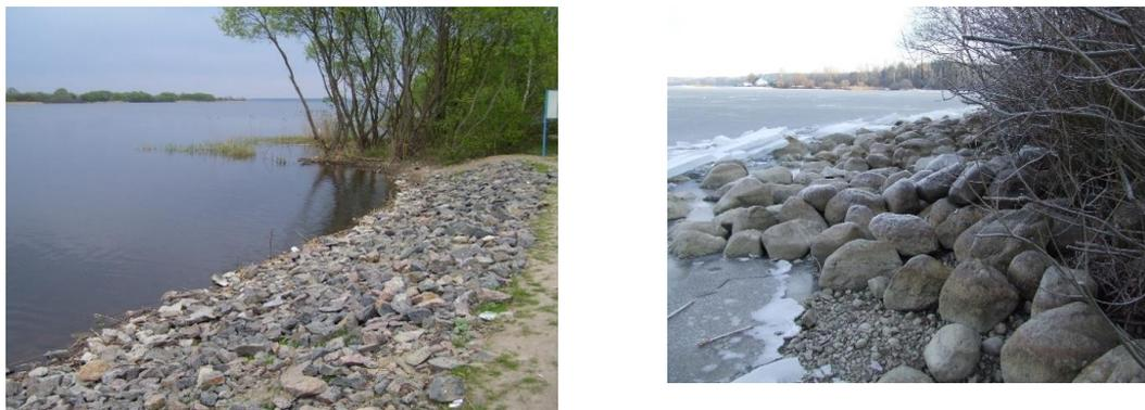
**Рисунок 1 – Крепление откоса камнем**
