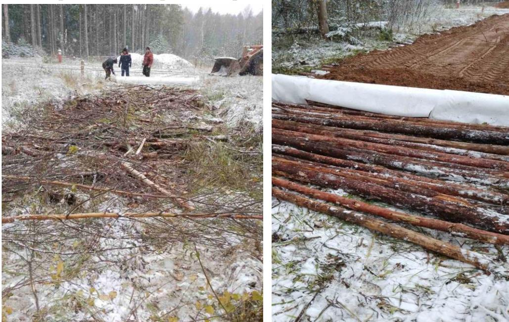
**Рисунок 1 – Укладка комбинированной прослойки**
