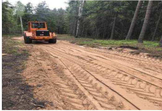
Рисунок 11 – Отсыпка насыпного слоя
