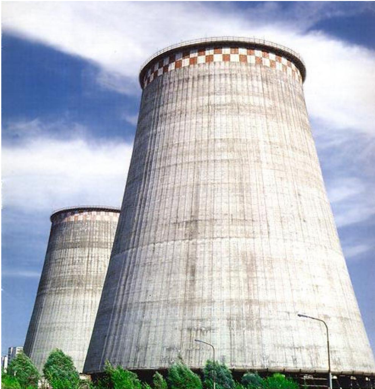
Рис. 2.4. Внешний вид башенной градирни
