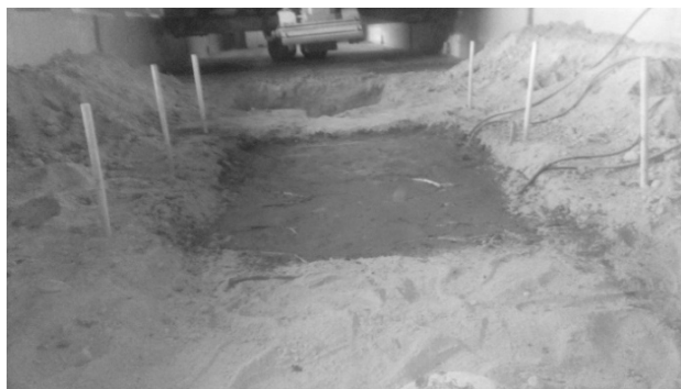
Рис. 1. Фото опытного участка дорожной конструкции с использованием георешетки
