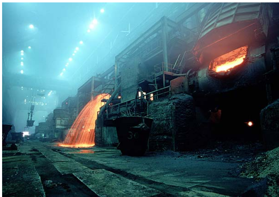
Рис. 55. Конвертерный пролет на ОАО «ГМК «Норильский никель» [10]
