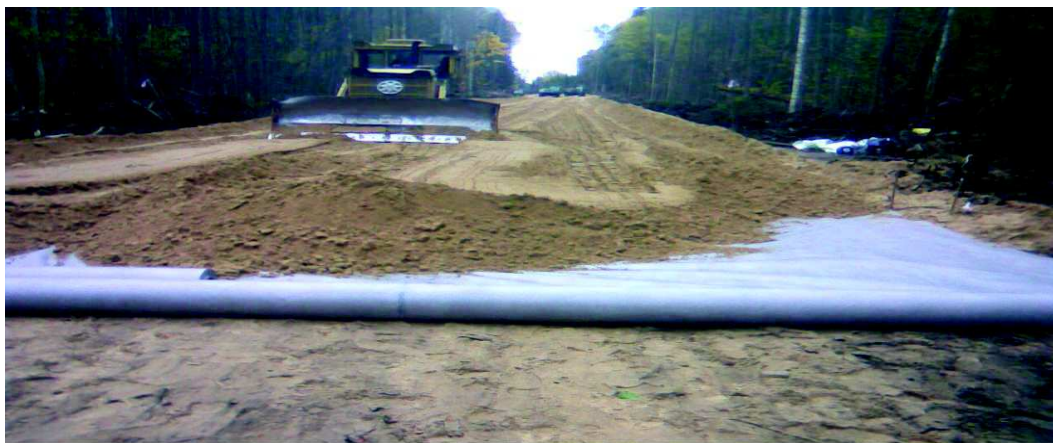
Рисунок 6 – Строительство опытного участка
