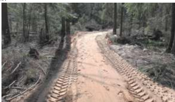
Рисунок 4- Вид участка дороги после строительства
