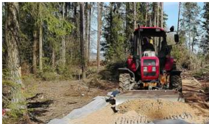
Рисунок 3- Строительство опытного участка лесной дороги
