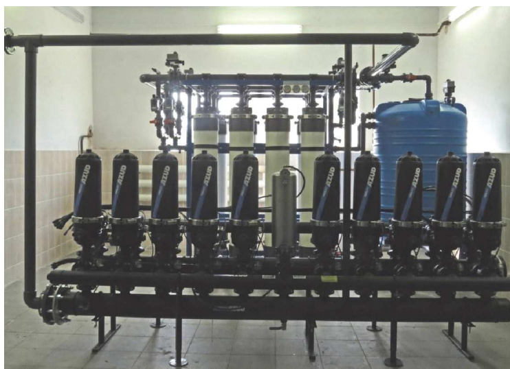
Рисунок 4 – Общий вид автоматизированной очистной установки
