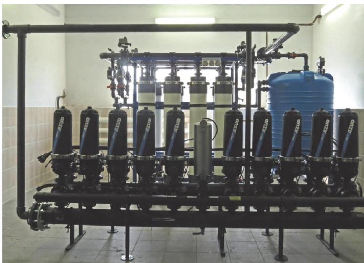
**Рисунок 4 – Общий вид автоматизированной очистной установки**
