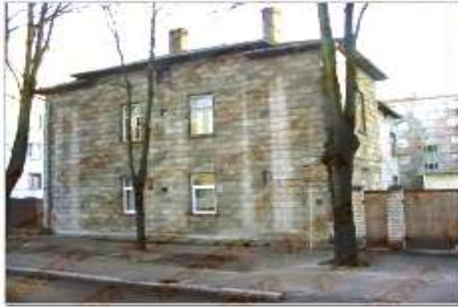
**Рисунок – Здание из ячеистого бетона автоклавного твердения без наружной отделки (1939 г., г. Рига, ул. Эльвирас, 15)**
