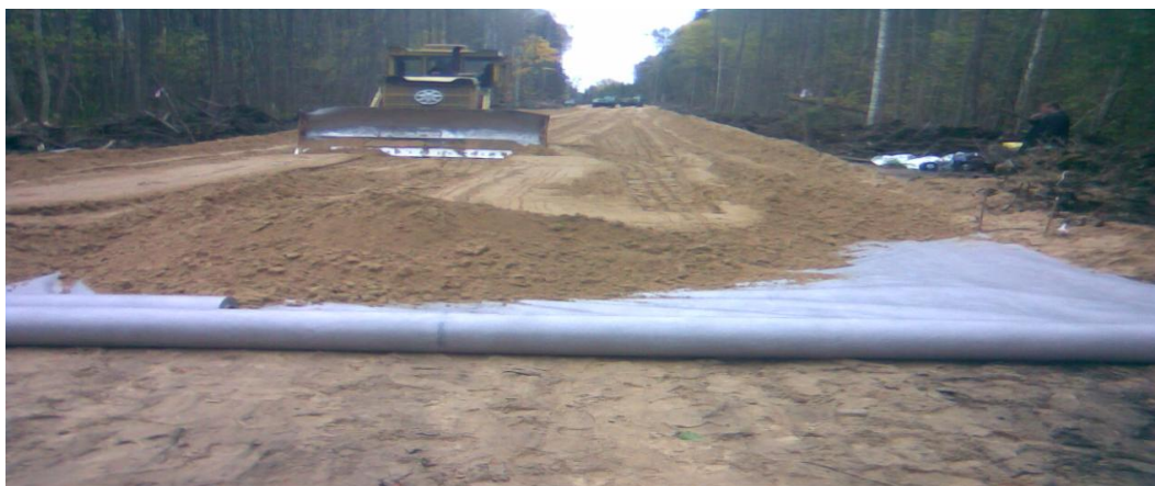
Рисунок 6 – Строительство опытного участка
