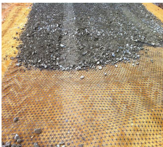
Рисунок 4 – Применение геосеток для устройств дорожных одежд
