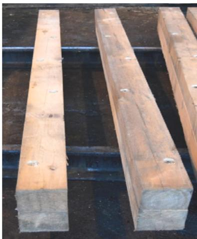
Рис. 2. Комбинированная сборная шпала
