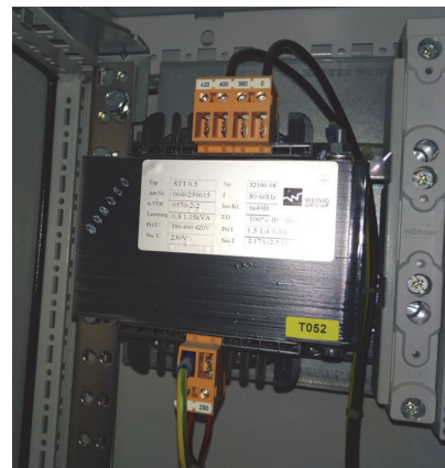
Рис. 8.13. Устройства преобразования тока и напряжения: а – выпрямители тока силовой цепи и цепи управления; б – трансформатор напряжения (TV)
