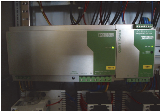
Рис. 8.13. Устройства преобразования тока и напряжения: а – выпрямители тока силовой цепи и цепи управления; б – трансформатор напряжения (TV)
