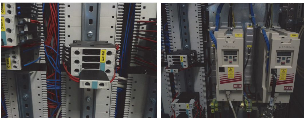
Рис. 8.14. Пускатель ( а ) и частотный преобразователь ( б ) асинхронных двигателей оборудования
