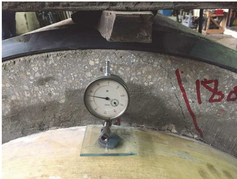
Рис.4. Внешний вид наклонной трещины в шельге
