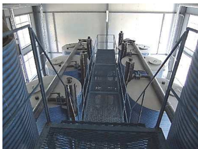
Рисунок 2. Общий вид безнапорной станции обезжелезивания ( a ) и системы аэрации биореактора
