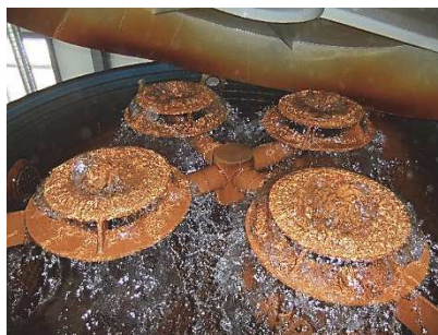
Рисунок 2. Общий вид безнапорной станции обезжелезивания ( a ) и системы аэрации биореактора
