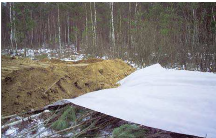
Рис. 3. Строительство опытного участка в Осиповичском лесхозе
