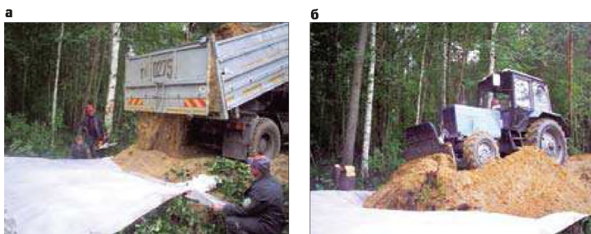
Рис. 4. Строительство опытного участка в Кличевском лесхозе: а — отсыпка земляного полотна лесной дороги; б — разравнивание слоя земляного полотна
