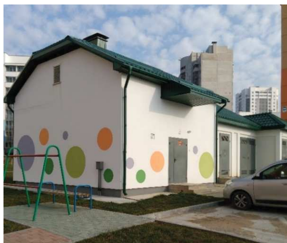
Рисунок 2 – Трансформаторная подстанция в городе Гродно
