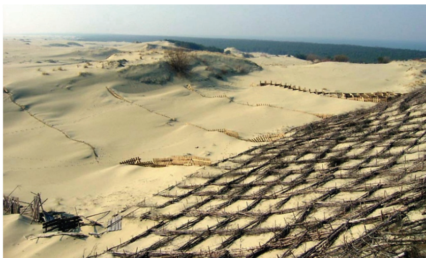
Рис. 27. Закрепление подвижных песков механическими рядовыми и клеточными защитами
