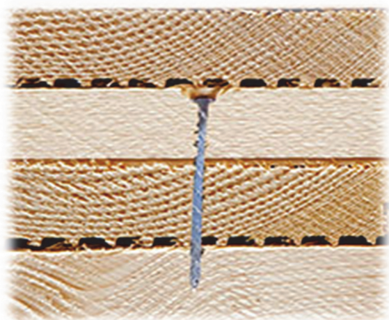
Рис. 2. Соединение досок в слоях плиты МНМ
