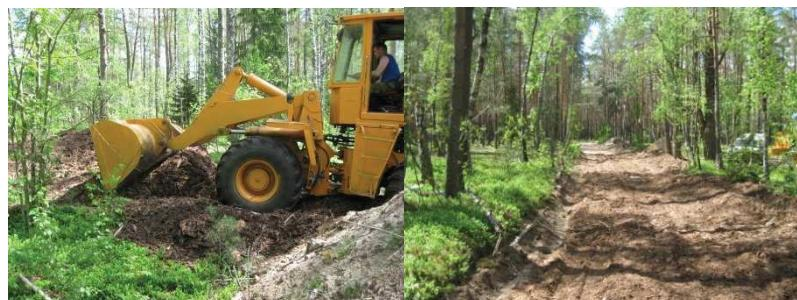
**Рисунок 5 – Работа погрузчика при разравнивании отходов по дорожному полотну**
