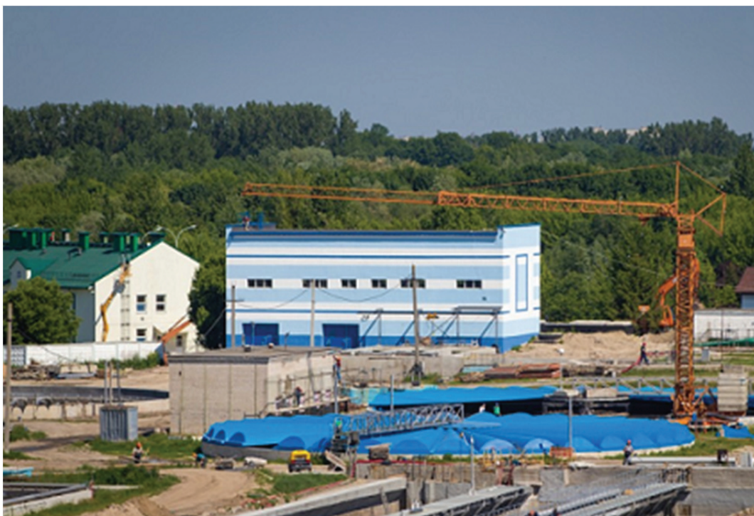
Рисунок – Первичный отстойник с герметичным перекрытием
