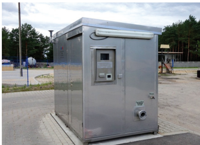
Рисунок 7 – Станция приема стоков
