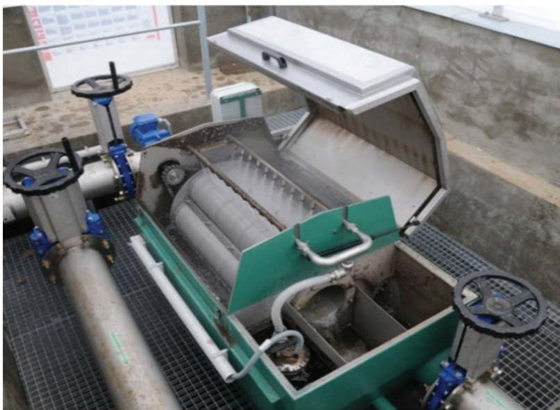
Рисунок 6 – Мелкоячеистый фильтр барабанного типа
