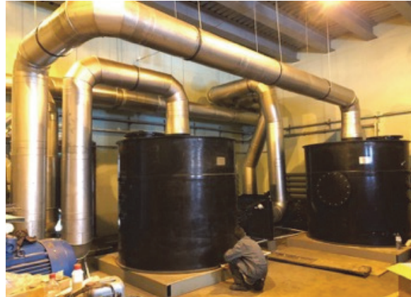
Рисунок 6 – Установка адсорбционных фильтров на Василеостровской канализационной насосной станции (ГУП «Водоканал Санкт-Петербурга»)
