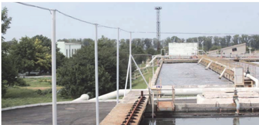
Рисунок 8 – «Мокрый барьер» на первичных отстойниках
