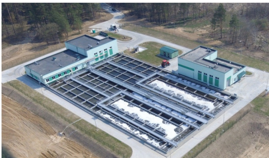
Рисунок 3 – Зоны очистки, расположенные в одном корпусе биореактора
