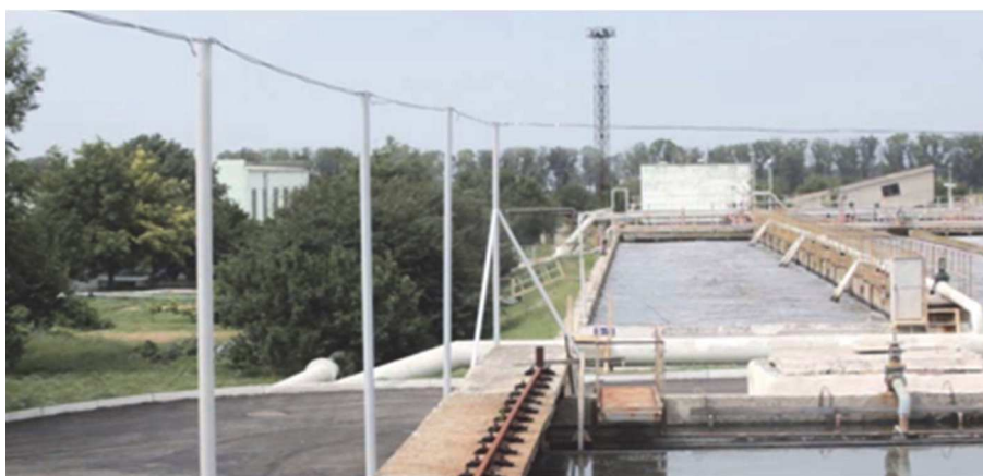
Рисунок 8 – «Мокрый барьер» на первичных отстойниках
