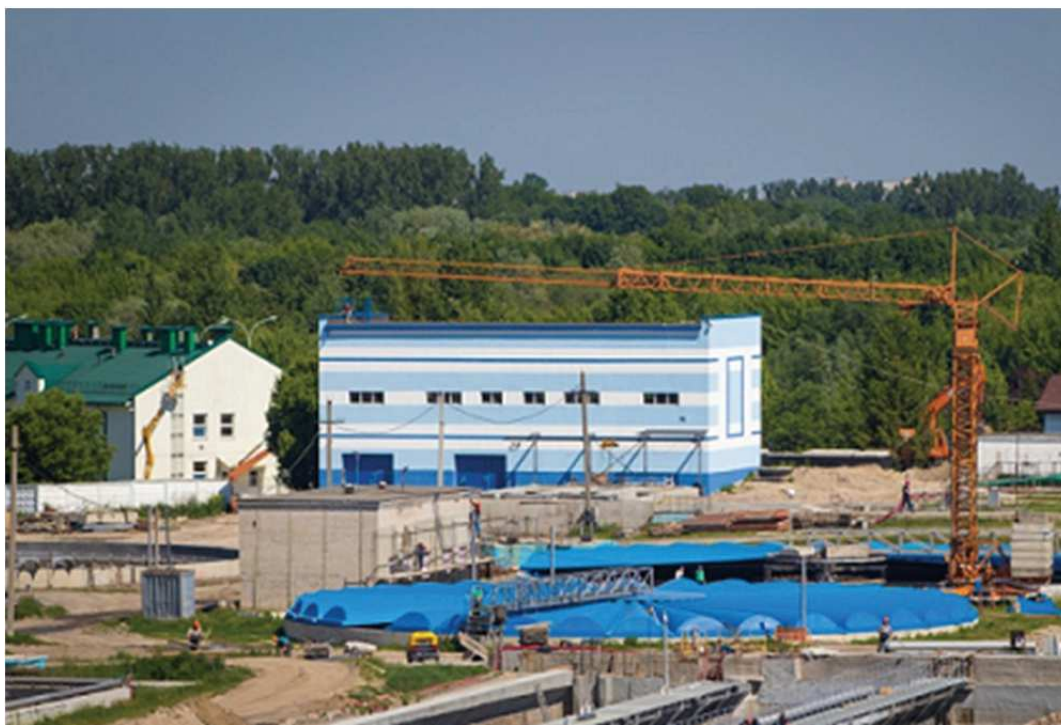
Рисунок – Первичный отстойник с герметичным перекрытием
