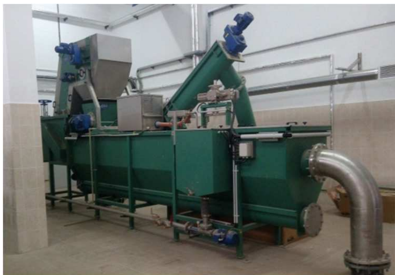
Рисунок 5 – Комбинированная установка механической очистки с песколовкой и гребельной решеткой
