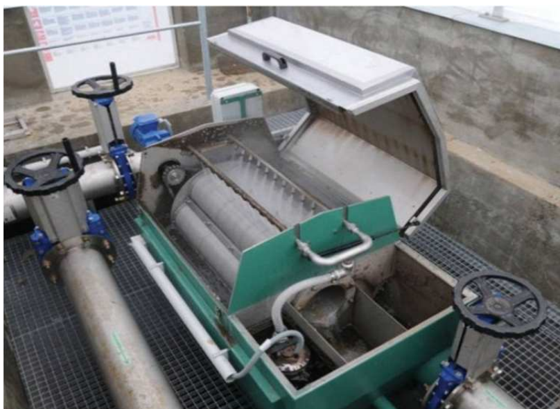
Рисунок 6 – Мелкоячеистый фильтр барабанного типа
