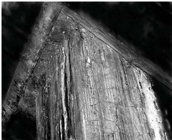
Рис. 4. Поражение стойки стропильной системы белым домовым грибом
