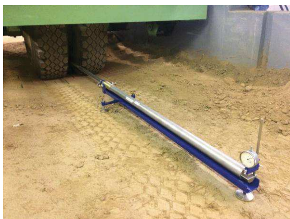
Рисунок 5 – Измерение модуля упругости прогибомером на грунтовом канале
