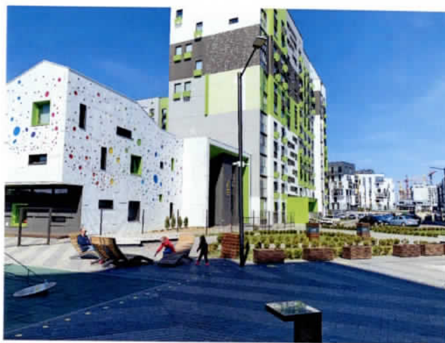
Фото 13. Архитектурный облик застройки жилого комплекса «Новая Боровая» в Минске
