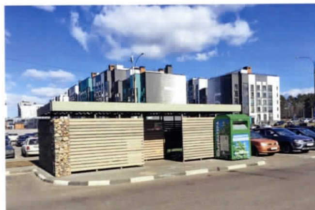
Фото 17. Павильон для раздельного сбора мусора, расположенный рядом с парковкой личных автомобилей жильцов. Жилой район «Новая Боровая» в Минске
