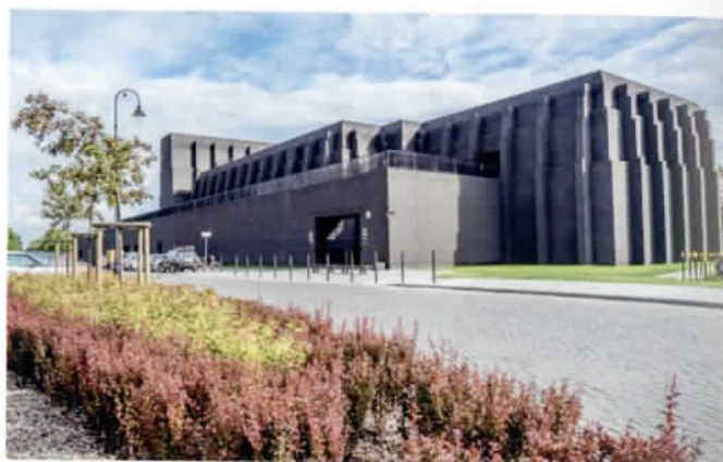
11. Здание Гданьского Шекспировского театра с раскрывающейся крышей (архит. Р. Рицци)
