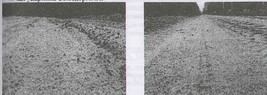
Рисунок 3 – Колея на участке без георешетки (а) и на участке с георешеткой (б)
