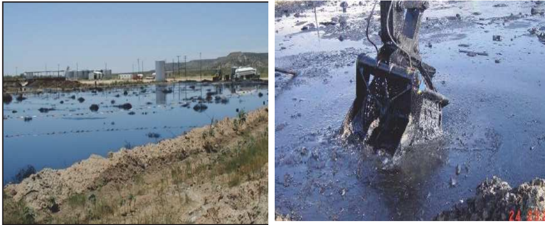
Рисунок 1 – Фото 1 – Шламовый пруд; Фото 2 – Шламовый накопитель
