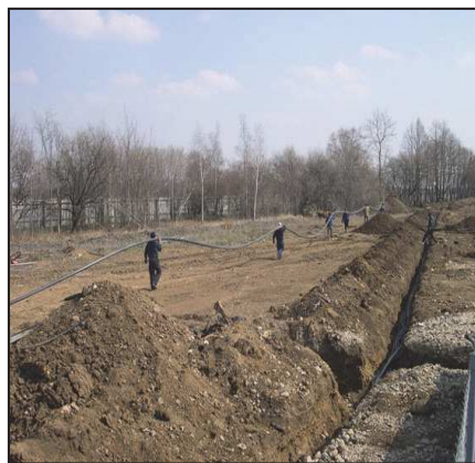
Рисунок 2 – Рекультивация нефтезагрязненных грунтов методом Биоремедиация “in -situ”
