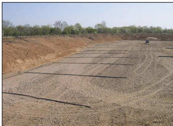
Рисунок 2 – Рекультивация нефтезагрязненных грунтов методом Биоремедиация “in -situ”
