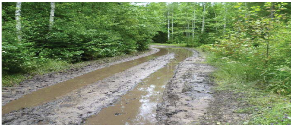
Рис. 1- Образование колеи до 70 сантиметров
