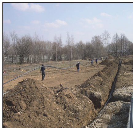
Рисунок 2 – Рекультивация нефтезагрязненных грунтов методом Биоремедиация “in -situ”
