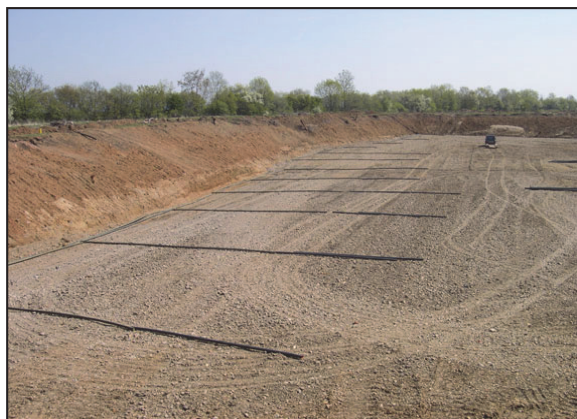
Рисунок 2 – Рекультивация нефтезагрязненных грунтов методом Биоремедиация “in -situ”
