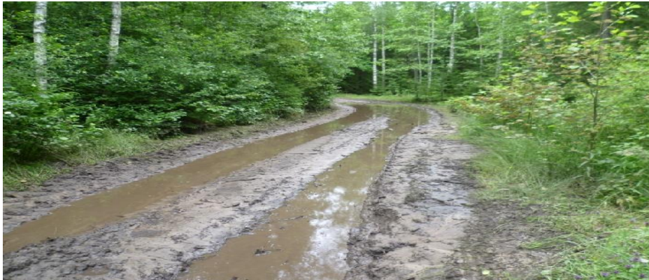
Рис. 1- Образование колеи до 70 сантиметров
