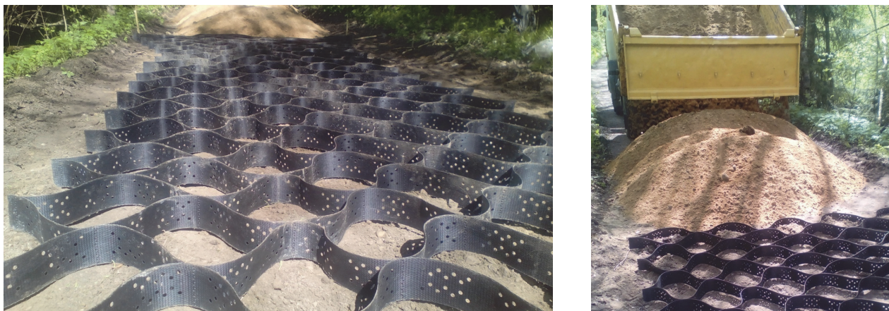
Рис. 4. Укладка в корыто и отсыпка георешетки
