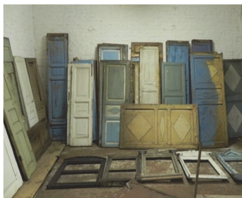
Рис. 11. Демонтированные старые двери
