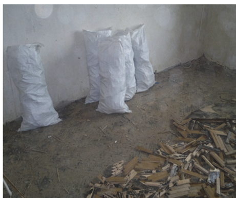
Рис. 9. Отходы после демонтажа пола
