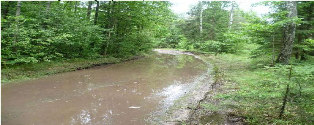
Рисунок 3 – Продавливание грунта
