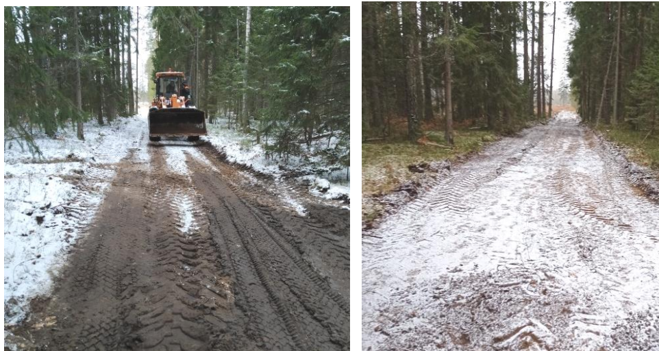
Рисунок 5 – Формирование корытообразного профиля на объекте 2
