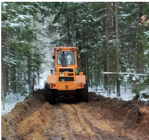
Рисунок 4 – Формирование корытообразного профиля на объекте 1
