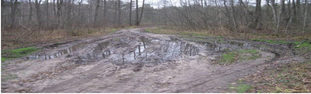
Рисунок 2 – Сплошное разрушение
