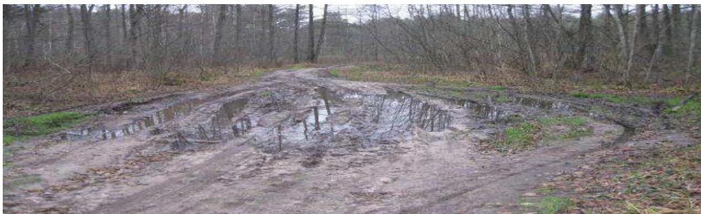
Рисунок 2 – Сплошное разрушение
